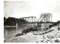
(枇杷島橋建設)
